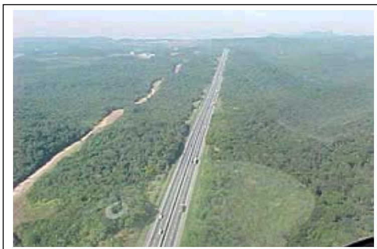
Figura 03 - Linha de dutos enterrados ao lado da Rodovia dos Imigrantes - S P
