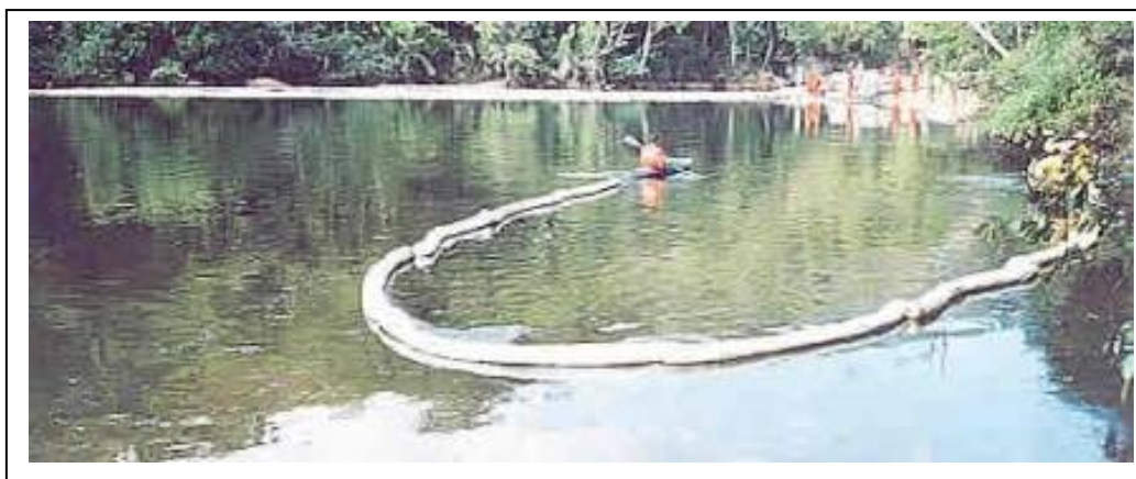
Figura 43 - Barreiras absorventes
