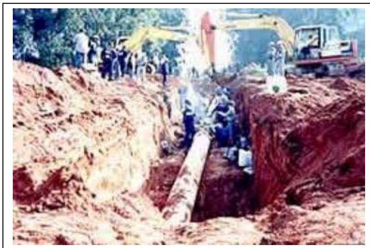
Figura 02 - Linha de oleoduto em reparo
