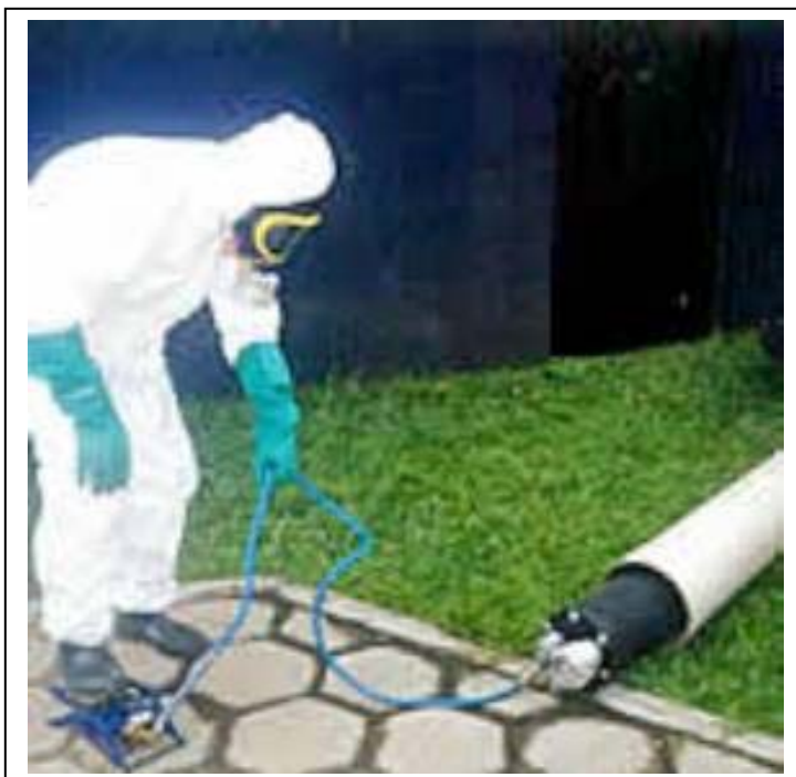
Figura 38 - Tampão de Neoprene e Conjunto Batoque
